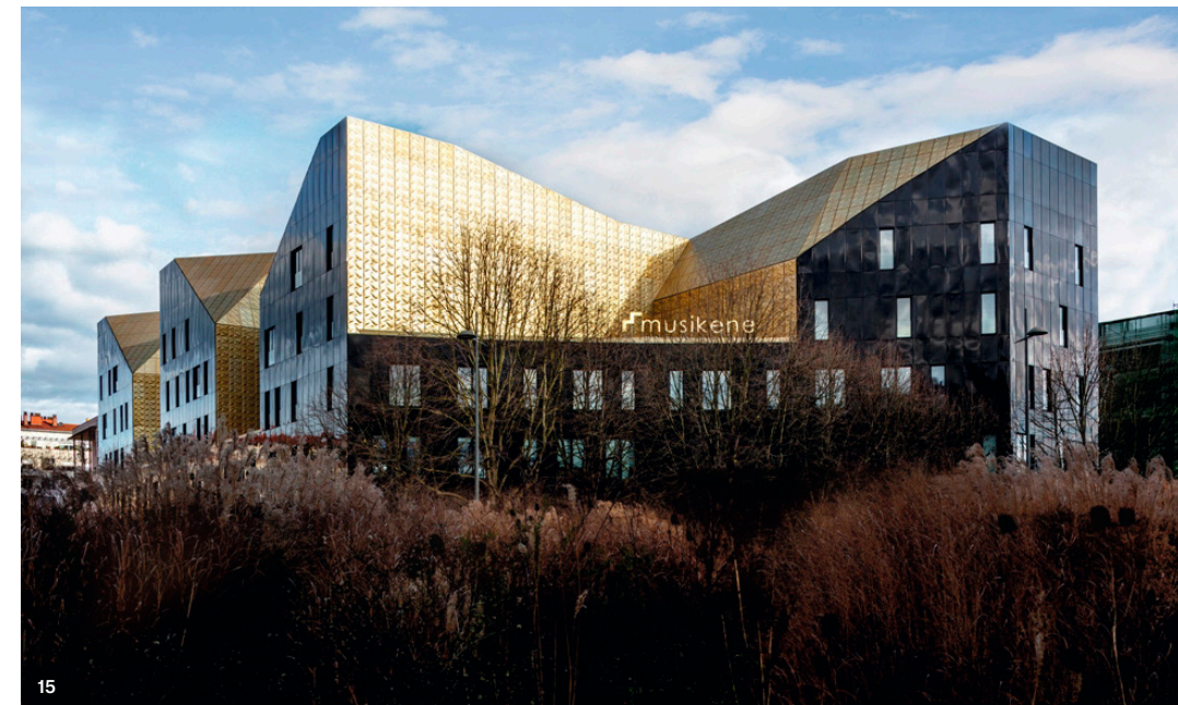
14. Sede de Osakidetza (Servicio vasco de salud), Coll Barreu. Bilbao (Bizkaia), 2008. 15. Musikene, GAZ Arquitectos. Donostia/San Sebastián (Gipuzkoa), 2001.
